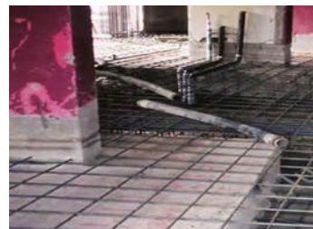
Fig. 17. Consolidarea fundațiilor
