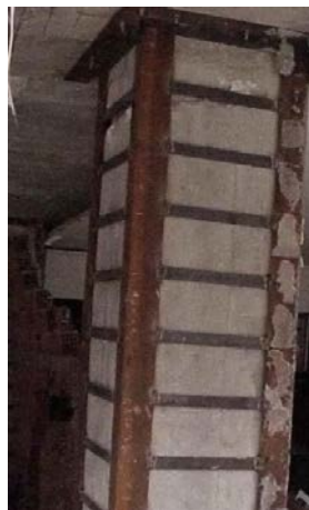
Fig. 14. Consolidare stâlpilor prin cămășuire Fig. 15. Consolidarea stâlpilor cu profile metalice
