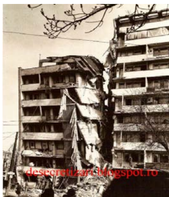
Fig. 4. Cedări ale elementelor structurale datorită seismului
