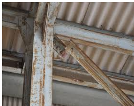
Fig. 10. Ruperea componentelor structurii
