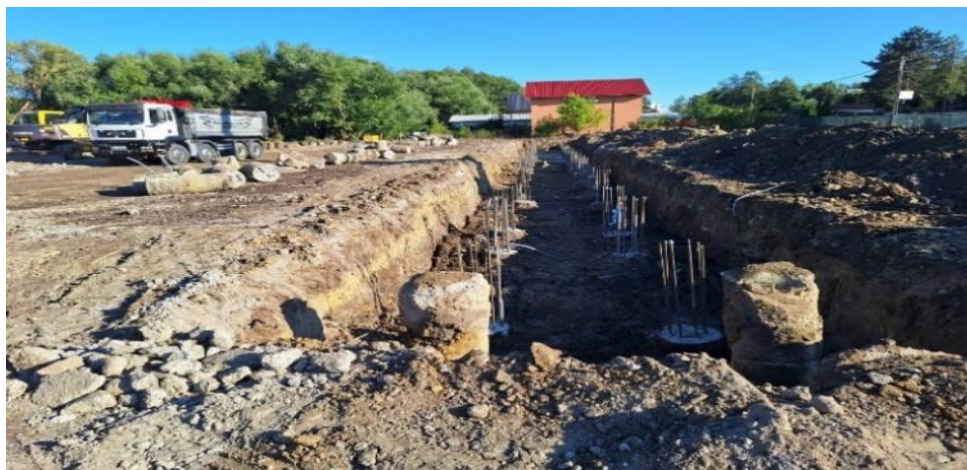
Fig.4. Săpătura fundațiilor izolate
