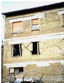
Fig. 2. Fisuri specifice zidăriei
