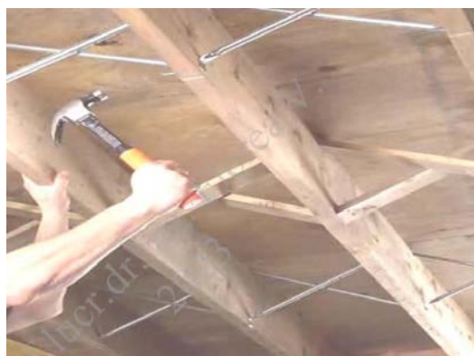
Fig. 20. Rigidizarea planșeului din lemn cu tiranți metalici
