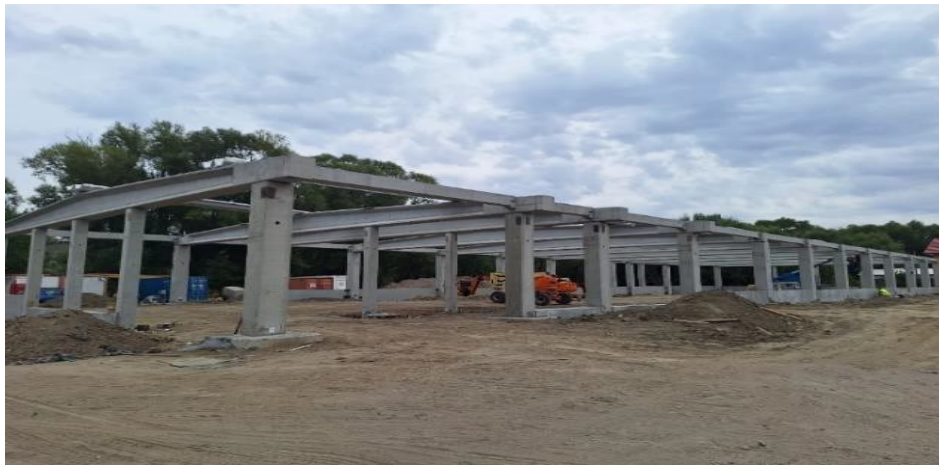
Fig. 5. Montaj elemente prefabricate
