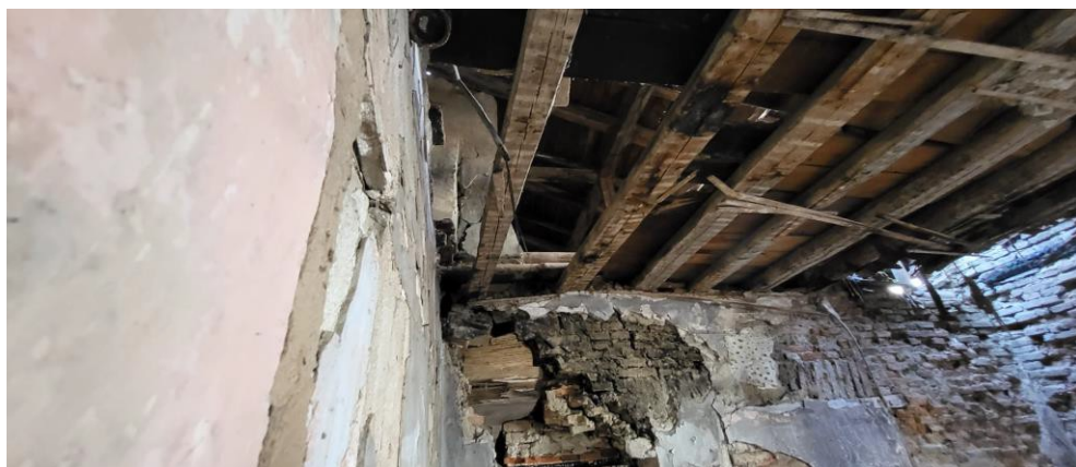
Fig. 3. Starea actuală a interiorului imobilului
