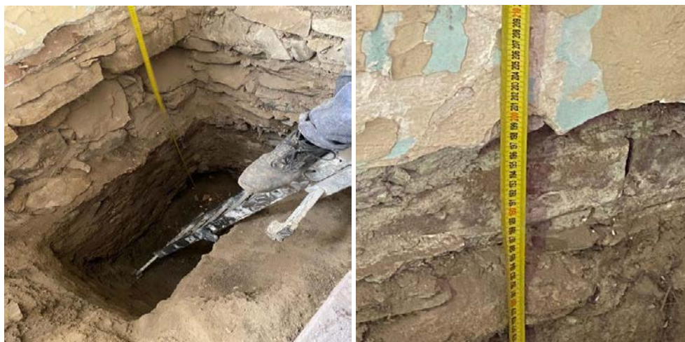
Fig. 2. Sondaj al fundațiilor existente
