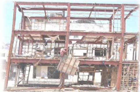
Fig. 11. Dislocarea componentelor structurii
