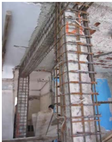
Fig. 14. Consolidare stâlpilor prin cămășuire Fig. 15. Consolidarea stâlpilor cu profile metalice
