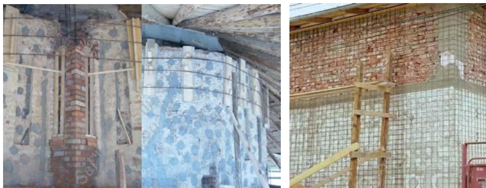
Fig. 12. Cămășuire pereți cu plase sudate, injectarea în perete a unui mortar de ciment fluid
