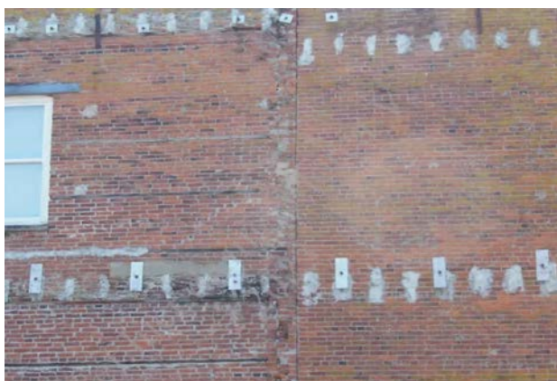
Fig. 13. Consolidare cu tiranți metalici
