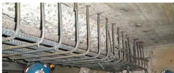
Fig. 16. Consolidare grinzilor prin cămășuire
