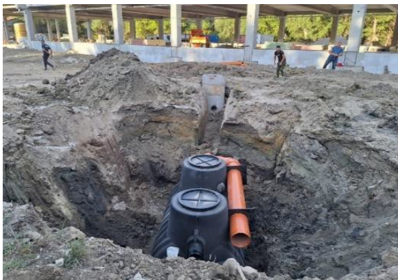
Fig.9. Lucrări de instalații exterioare
