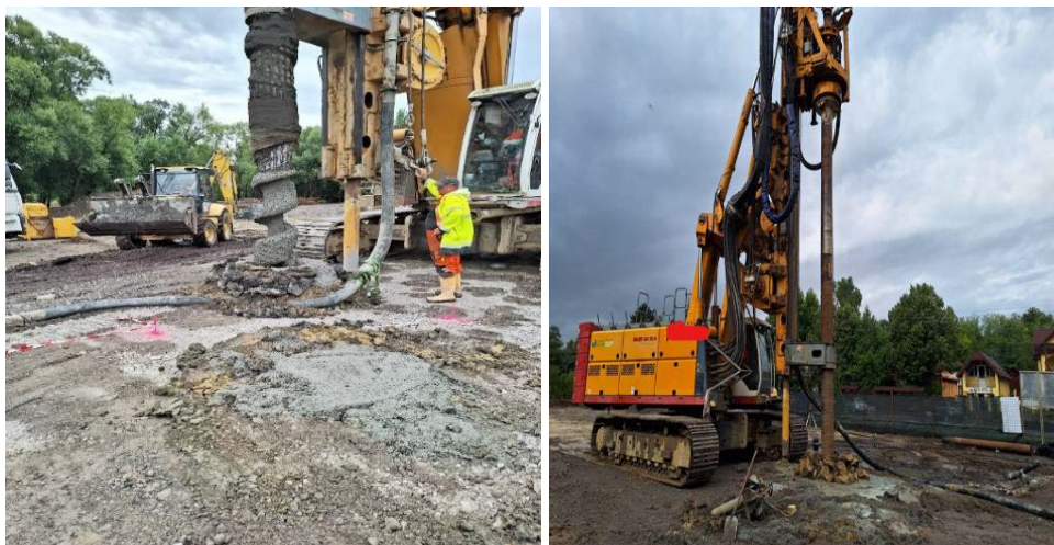
Fig. 2, Fig. 3. Forarea, betonarea și introducerea carcaselor de armătură pentru fundațiile speciale de tip piloți
