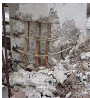
Fig. 6. Articulație plastică la baza stâlpului
