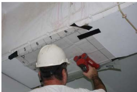
Fig. 11 – Măsurarea acoperirii cu beton cu ajutorul pacometrului PS 200 Ferroskan
