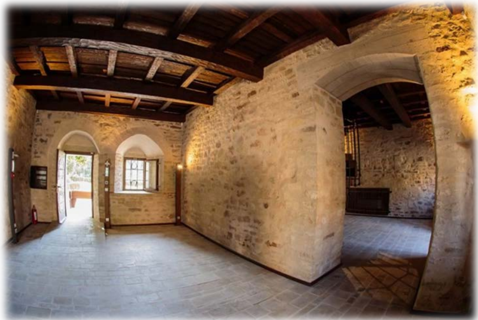
Fig. 7: Imagine după finalizarea lucrărilor de consolidare la nivelul zidăriei și a planșeului (arhivă Consiliu Județean Iași)
