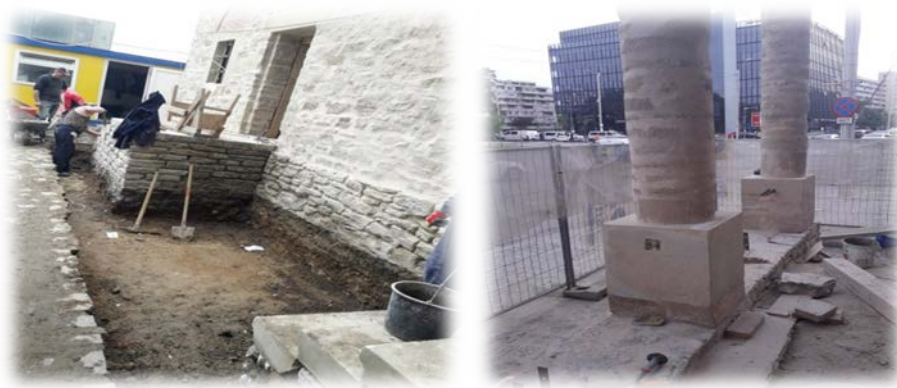
Fig. 6: Lucrări de consolidare a fundațiilor (arhivă Consiliu Județean Iași)
