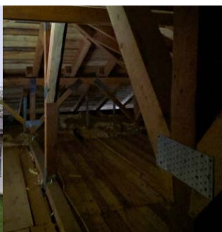
Fig. 14. Aspect șarpantă după intervenție
