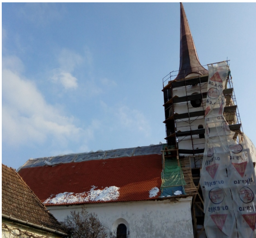
Fig.1. Imagine din timpul execuției lucrărilor de schimbare a învelitorii
