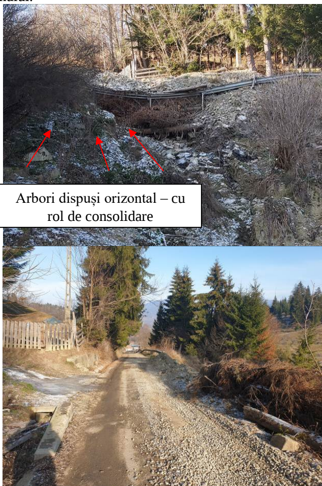
Fig. 5 – Arbori dispuși în corpul drumului
