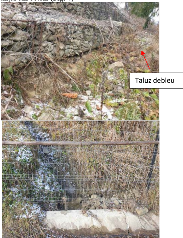
Fig.3- Structura din gabioane
