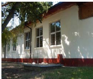
Fig. 9. Aspect exterior fațadă principală înainte de intervenție
