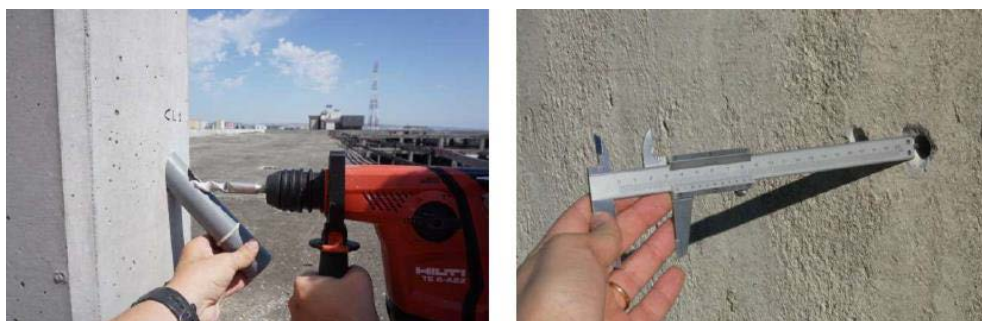
Fig. 14 – Prelevare probe pentru măsurarea conținutului de cloruri
