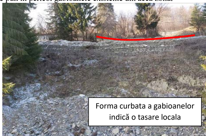
Fig. 8 – Tasare la nivelul gabioanelor
