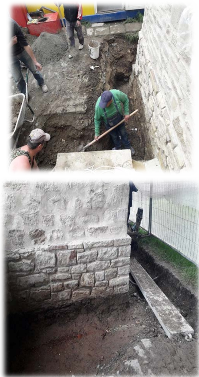
Fig.2: Imagini cu descoperirea fundațiilor din timpul lucrărilor (arhiva Consiliu Județean Iași)
