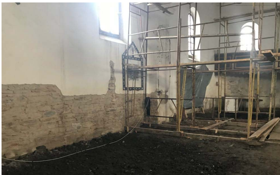
Fig.3: Imagine din timpul execuției lucrărilor de reparații la tencuieli
