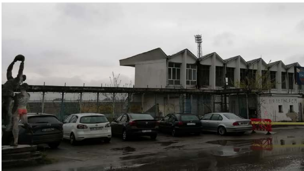
Fig. 6. Aspect exterior tribună Stadion Municipal Bacău.
