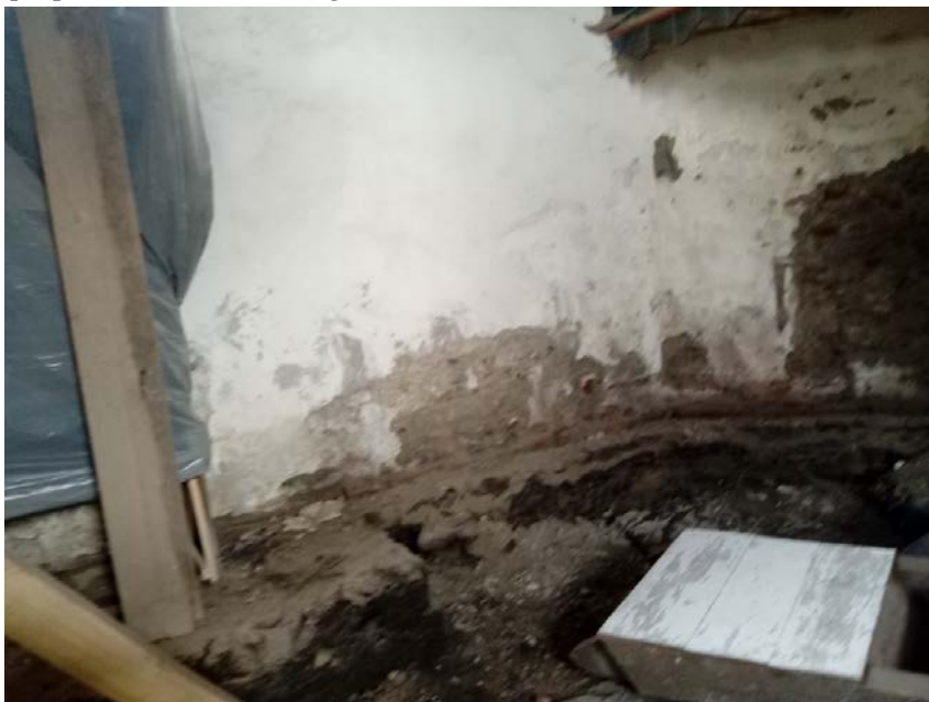
Fig.2. Imagine din timpul execuției lucrărilor de înlocuirea a pardoselii
