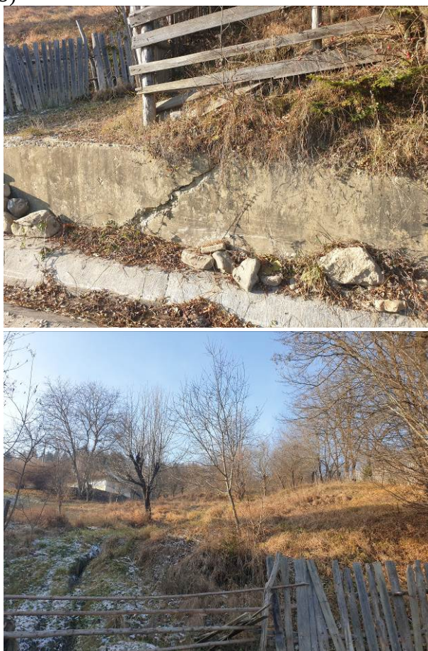
Fig. 9 – Zona de debleu al drumului
