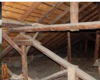
Fig. 11. Aspect șarpantă înainte de intervenție
