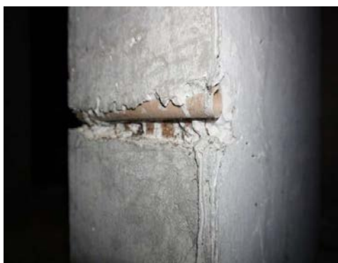
Fig.7 - Secționare stâlp din beton armat
