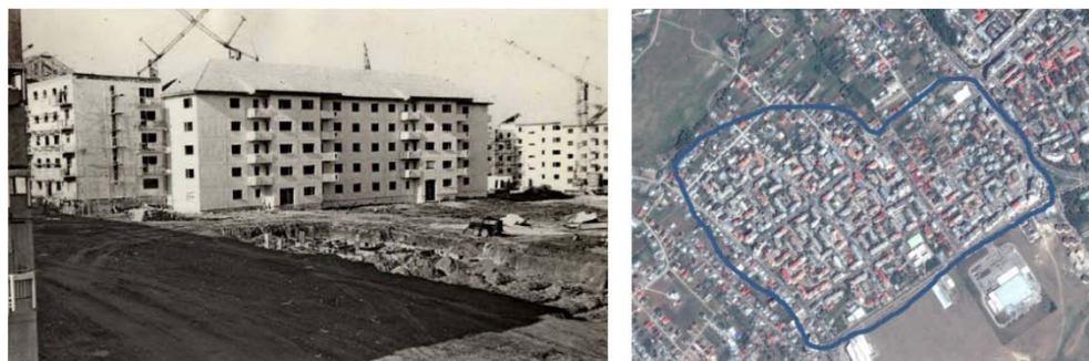
Fig. 19. Cartierul Obcini în construcție, anul 1988
