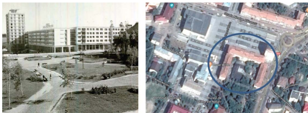
Fig. 10. Clădiri construite în perioada 1961-1963 în centrul Sucevei
