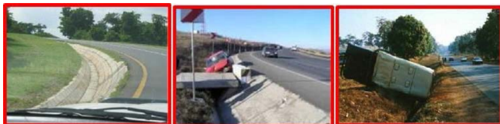
Fig. 1. Dispozitive periculoase pentru colectarea apelor pluviale
