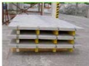
Figura 3 Sistemul HBV pentru planșeele compozite lemn-beton
