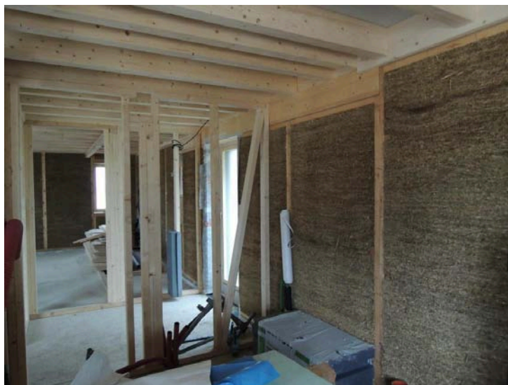
Fig. 5. Structură din lemn și panouri din lemn și paie ( http://www.caseecologice-info.ro/galerie/case-ecologice-casa-rezidentiala-2/#iLightbox[galerie]/8 )
