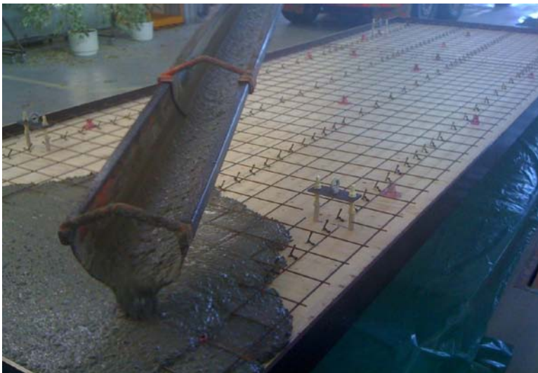
Fig.4. Turnarea betonului [Nežerka Václav]
