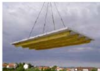
Figura 3 Sistemul HBV pentru planșeele compozite lemn-beton
