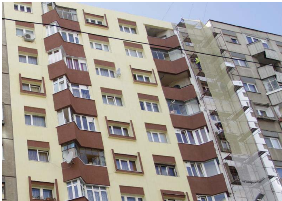
Fig. 4.1 – Reabilitarea termică a unui bloc de locuințe
