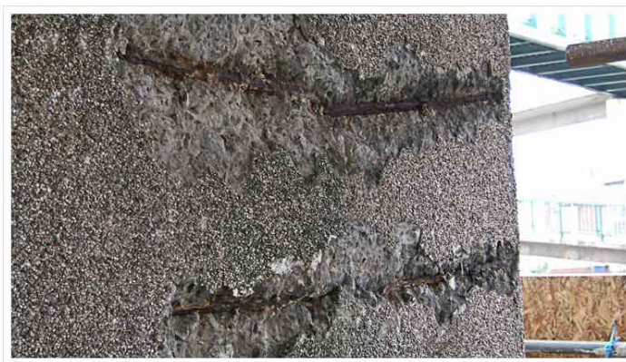
Fig. 3. Carbonatarea betonului
