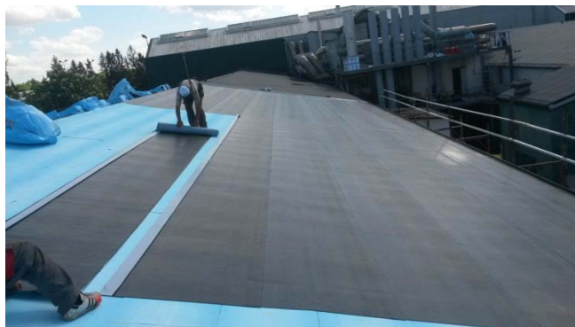
Fig. 2 Lipirea membranei autoadezive
