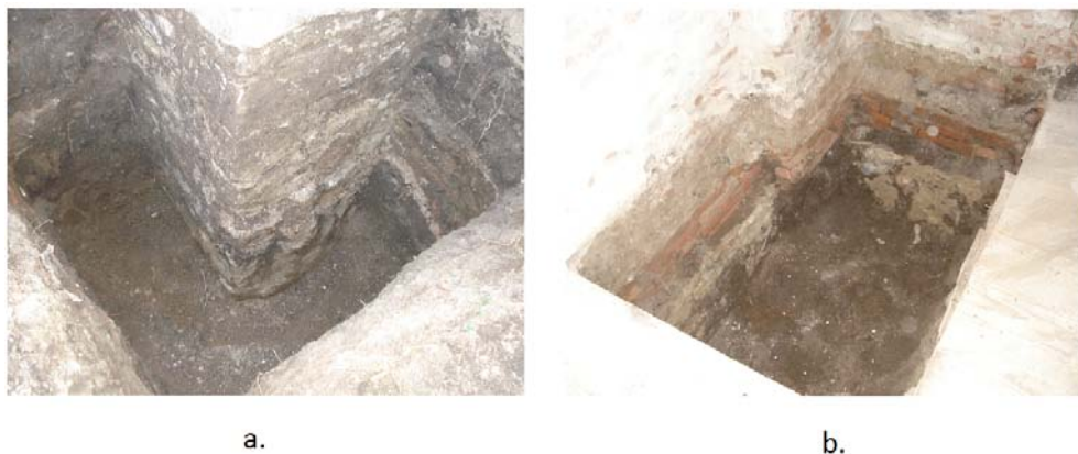
Fig. 8 Fundațiile din piatră exterioare și interioare
