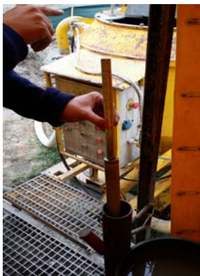
Fig.3. Măsurarea densității suspensiei de ciment cu areometru
