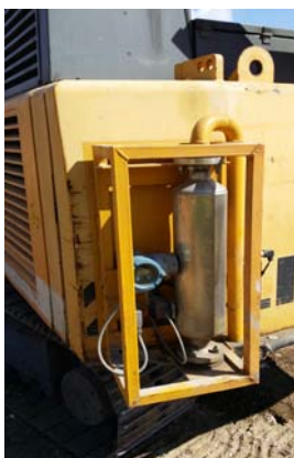
Fig.4. Dispozitiv montat pe echipamentul de malaxare pentru măsurare a densității suspensiei de ciment
