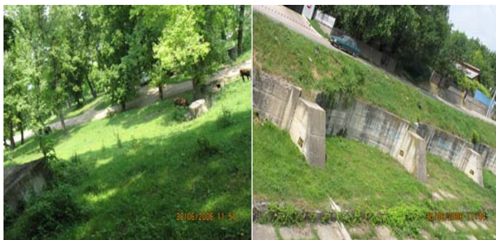
Fig. 3 – Zona versantului Galata – lucrări existente
