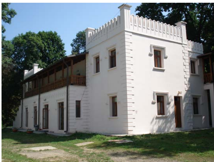
Fig. 11 Vedere de ansamblu a clădirii după finalizarea lucrărilor de intervenție
