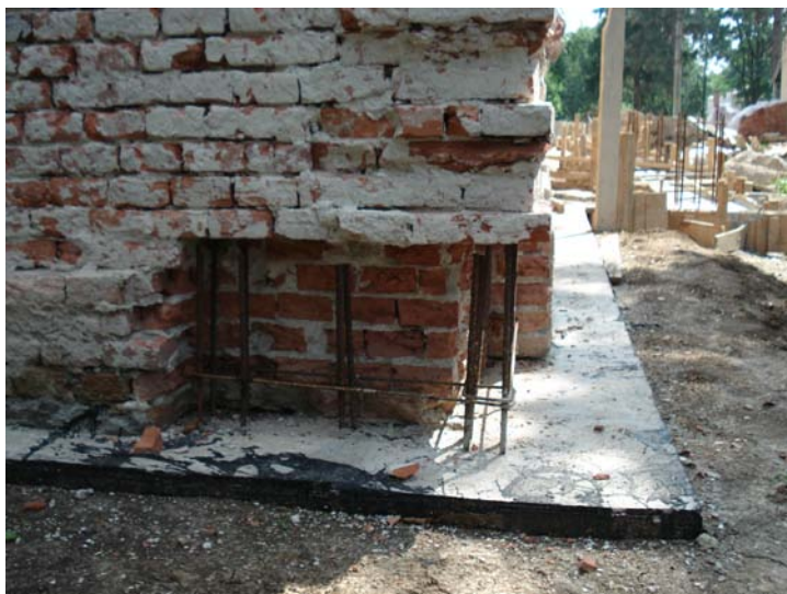
Fig. 10 Consolidarea fundațiilor din piatră
