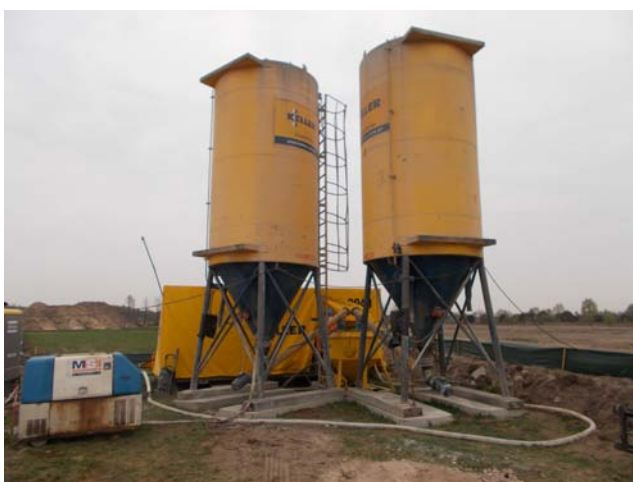
Fig.1. Silozuri utilizate pentru depozitarea cimentului
