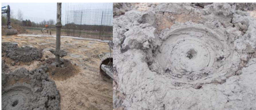
Fig.6. Elemente de tip coloană rezultate prin malaxare cu suspensie de ciment – Varșovia
