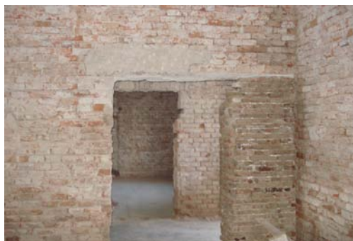
Fig. 7 Pereții portanți din zidărie de cărămidă – fotografie interioară cu evidențierea intervențiilor anterioare la suprastructură
