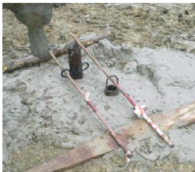
Fig.9. Ansamblul de tuburi introduse în interiorul unui element de tip coloană
