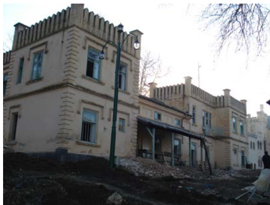
Fig. 6 Casa „Sf. Macrina” – Fațadă principală
