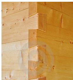
Fig. 2. Îmbinare coadă de rândunică
