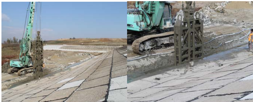
Aspecte din timpul execuției ecranului de etanșare la barajul Mileanca
