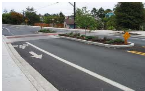
Figura 4. Exemplu trecere de pietoni securizată
