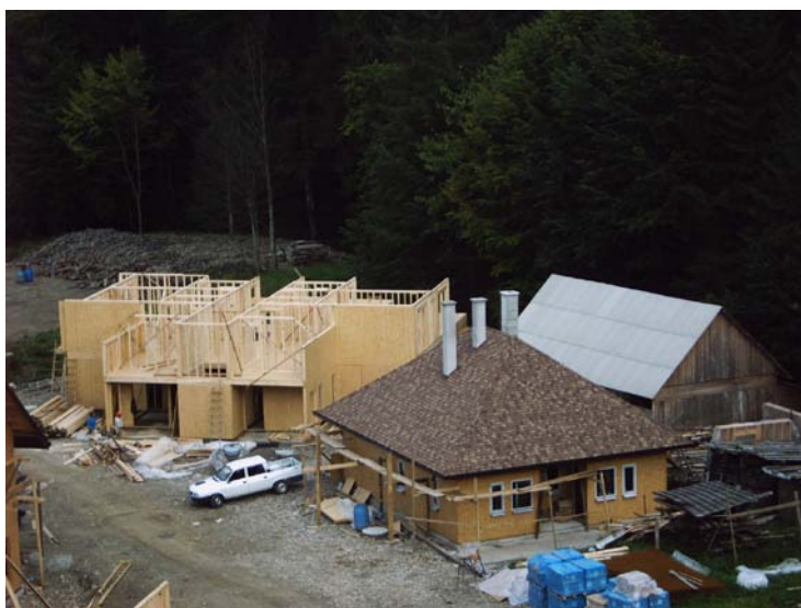
Figura 1. Imagine de pe șantier la montajul unei construcții prefabricate din panouri în localitatea Sucevița.
