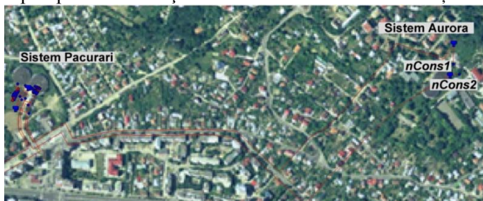
Fig. 2. Complexul Păcurari și rezervoarele Aurora
