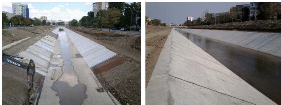
Fig. 2. Consolidarea malurilor râului Bahlui
