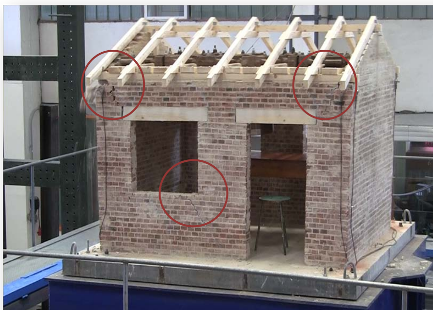
Fig. 14 Imagini din timpul testelor la acțiunea seismică
