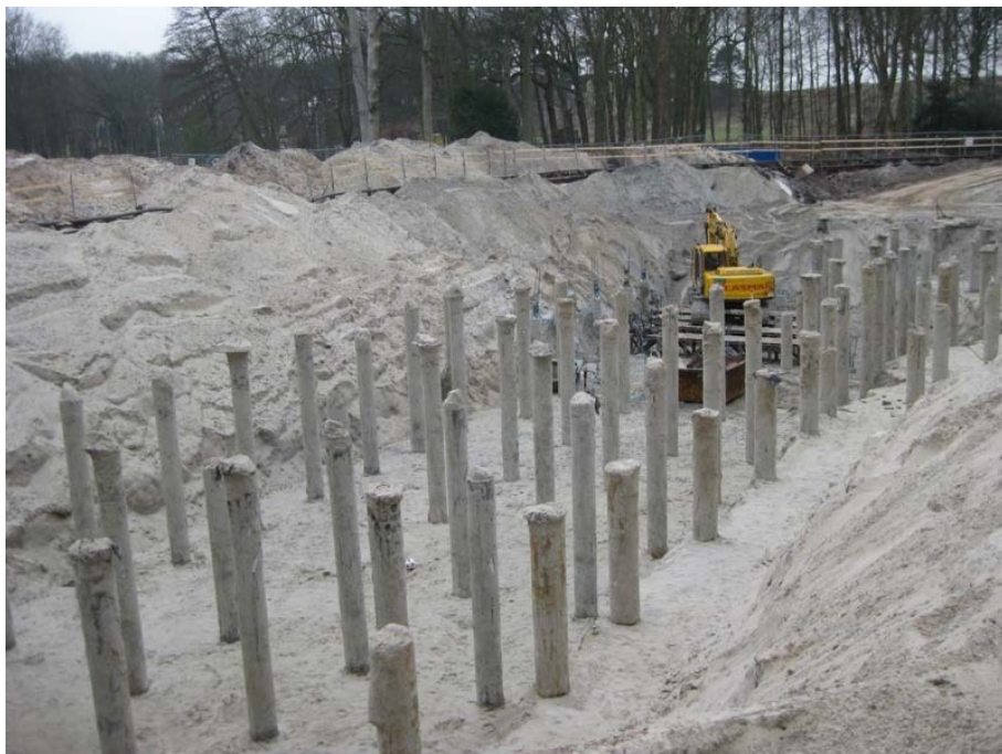
Figura 1- Piloți forăți de îndesare
